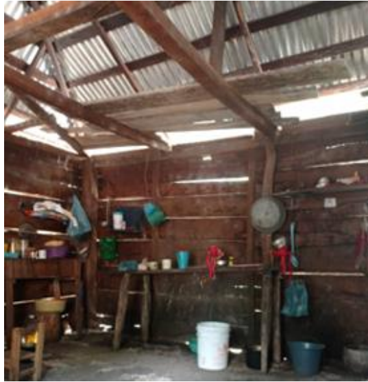
Imagen 1 Vivienda en la localidad de El Carmen II
